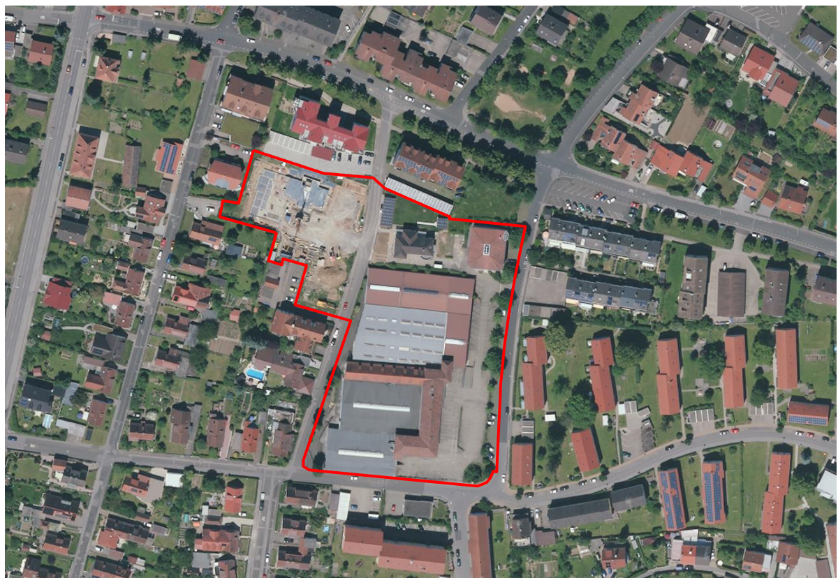
Abbildung 3: Luftbild, Geltungsbereich 6. Änderung rot (Kartengrundlage – RISBY, Bayerische Vermessungsverwaltung – Hinweis: Das bereits bestehende Wohnheim der Lebenshilfe findet sich noch nicht im Luftbild.)
