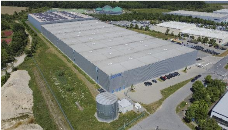
Abb. 2: Visualisierung der Einbindung der geplanten Lagerhalle in das Umfeld des Plangebietes (im Vordergrund: Bestandshalle; im Hintergrund: geplante Halle mit PV-Modulen auf dem Dach)
