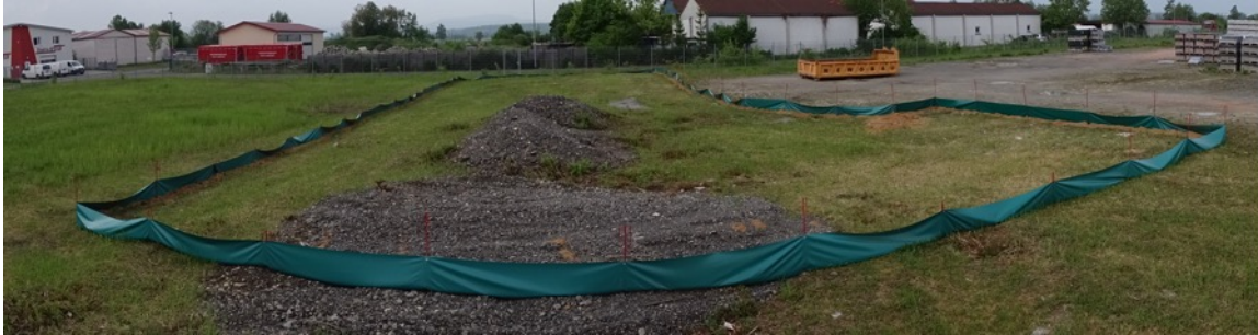
Abb. 10: Der im Bereich von Zauneidechsenhabitaten liegende Teil des Baufeld des Regenrückhaltebeckens wurde bereits mit einem Reptilienzaun abgesperrt.
