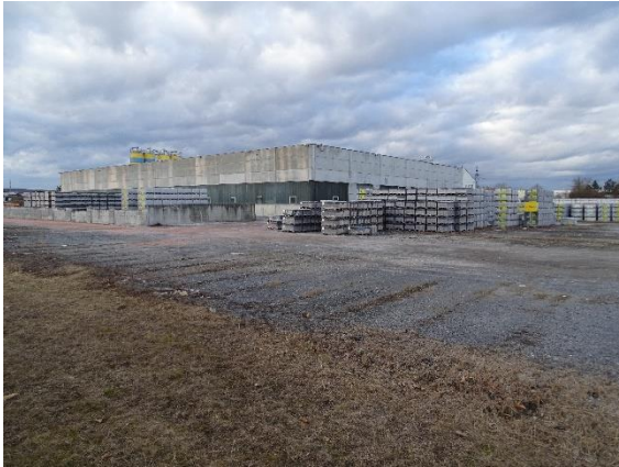
Abb. 4: Blick von Südosten auf das Produktionsgebäude.
