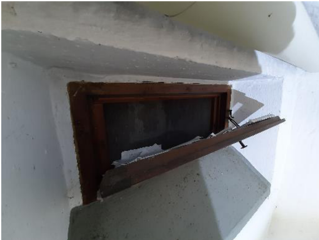
Abbildung 14: Im Keller des zentral gelegenen Wohngebäudes bestehen keine Einflugmöglichkeiten für Fledermäuse.
