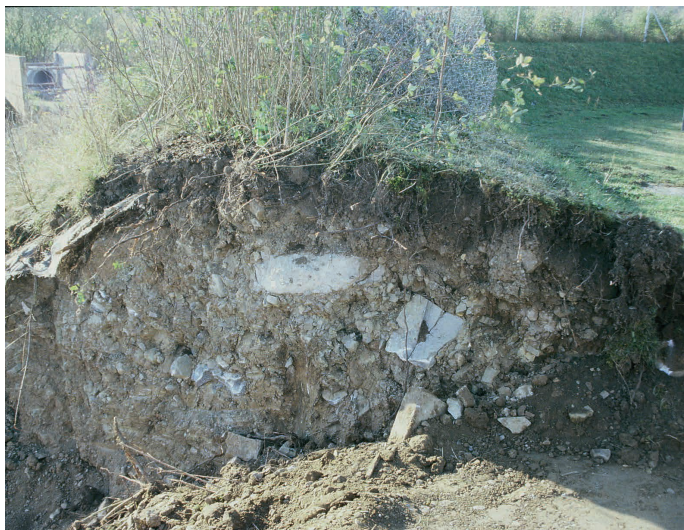
Fotos: Kläranlage, Stadt Haßfurt
