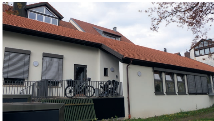
Der städtische Kindergarten „Die Stadtmäuse“ in Haßfurt wurde umfangreich saniert.
