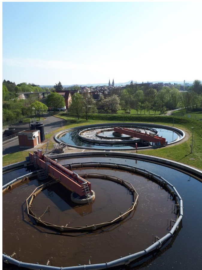
Bild: Kläranlage Stadt Haßfurt, Matthias Langguth
